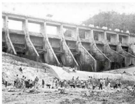
Construcción de la presa
