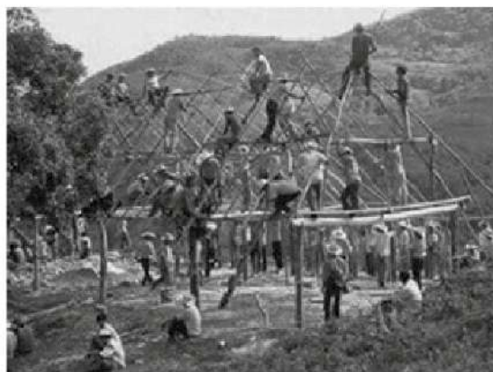
Trabajo colectivo antes del reacomodo forzado
