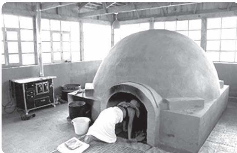
Fotografía 5 o El temazcal ya construido
